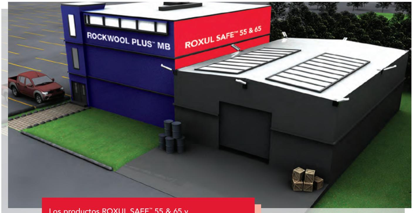
Los productos ROXUL SAFE™ 55 & 65 y ROCKWOOL PLUS™ MB se utilizan para aislar muros en edificios metálicos prediseñados. ROXUL SAFE™ 55 & 65 es especialmente apropiado para aplicaciones de eje neutro cuando los edificios están muy cerca uno al otro y por lo tanto la seguridad contra incendios es un factor esencial.
